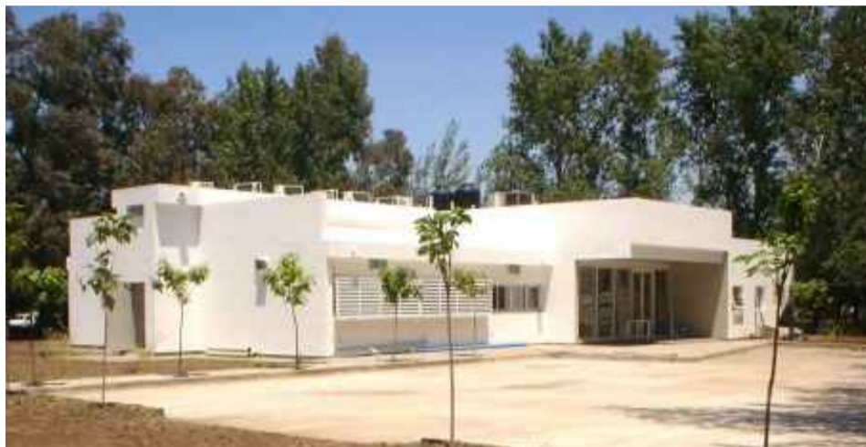
Flamante edificio del LabCap.
